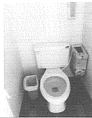
Hace falta la instalación de partes de inodoros, tales como: palancas y asientos.
